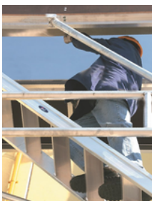
Passagem completa com tampa para acesso ao último nível
