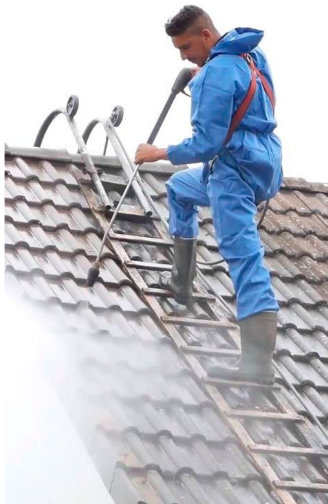
Escada de telhado
